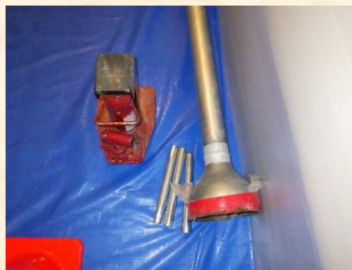
【白ガス管（50A）に150×50AのRS溶接し治具を作成】
