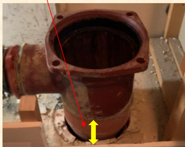
【排水用特殊継手ジャッキアップ状況】
