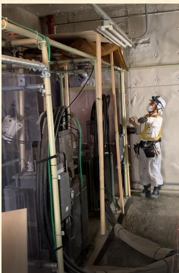
【トランス上部養生状況】
