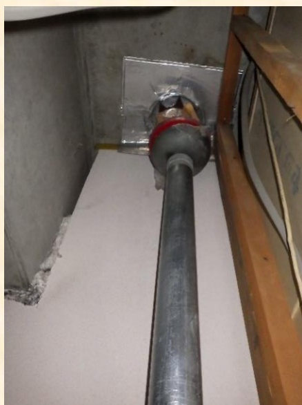
【排水用特殊継手を押し上げている状況】
